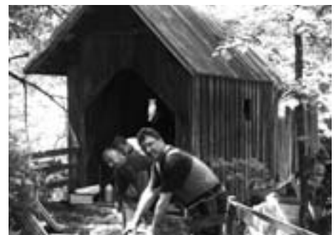
Sanierung der Fußgängerbrücke
